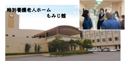
特別養護老人ホーム もみじ館 常時介護を必要とし、在宅での生活が困難な高齢者に対して生活全般の介護を提供する施設で、入所条件として要介護3以上の認定を受けた高齢者が対象
